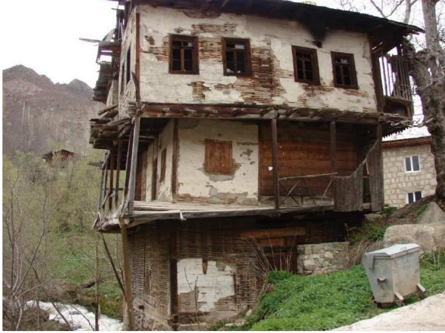
Fotoğraf 3: Bağdadi tarzda yapılmış ve bazı kesimlerde sıvasının dökülmesi sonucu ızgaralı yapının görülebildiği eski çakatura dolma evden bir görünüm.
